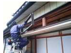
新しい枠を取り付けます。
